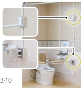
トイレ離座検知システムを設置したトイレ
