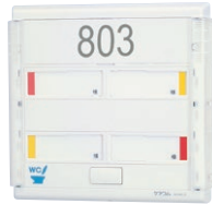
個別廊下灯(4床室(トイレ付)用)
